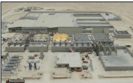
Doha (Qatar) 15 digesters for 301'400 t/y (OFMSW & SSO)
